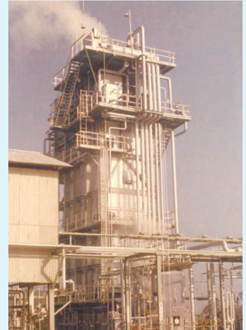
台灣第一座天然氣裂解爐（苗栗廠；1964年）
